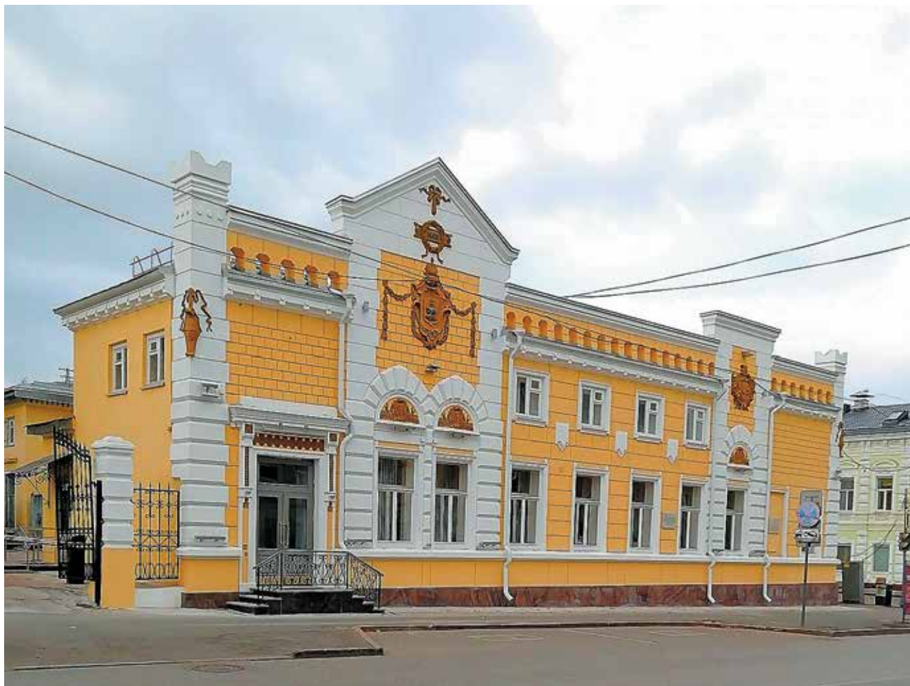
Дом губернатора после реконструкции. Пермь, ул. Сибирская
